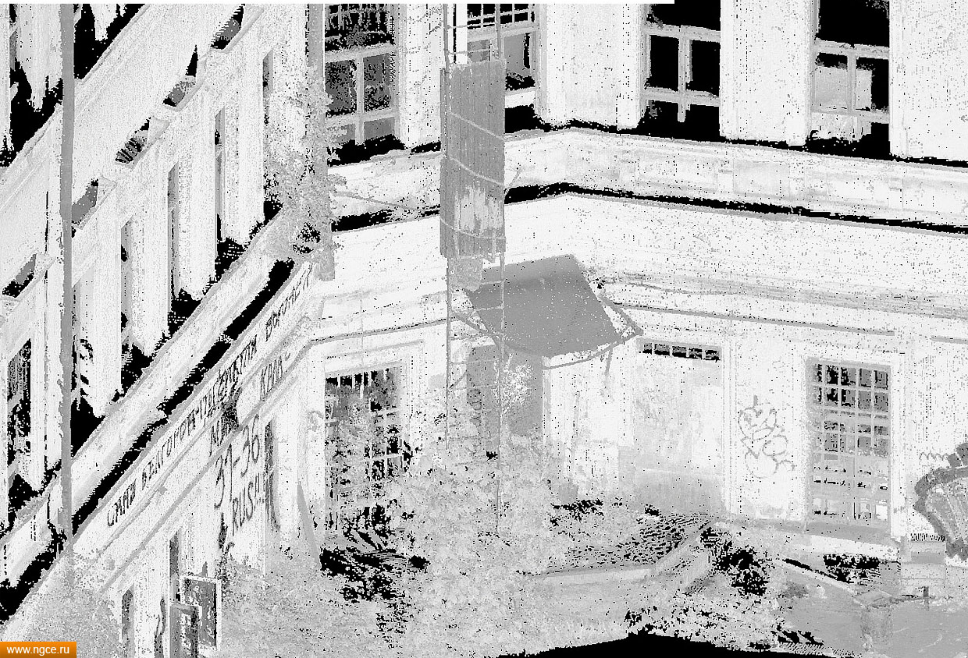
Фрагмент облака точек заднего фасада «Дома с атлантами», выходящего во внутренний двор
