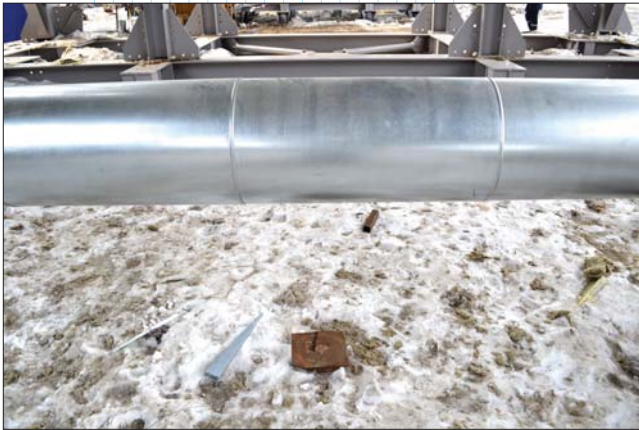
Рис. 1. Репер под трубой
